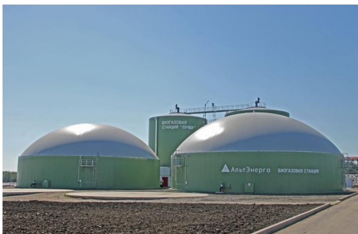
Рис. 4.14. Биогазовая станция «Лучки»
